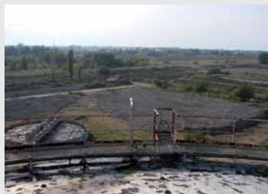
Foto 6: Prática deficiente: armazenamento nas instalações da ETAR visitada
