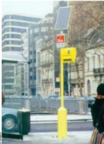
A tecnologia fotovoltaica coloca energia eléctrica em aparelhos autónomos, como estações meteorológicas, parquímetros, telefones de urgência e, aqui, num painel informativo de uma paragem de autocarros.
