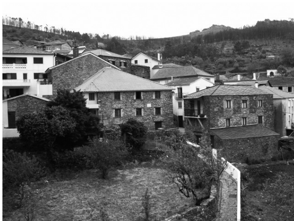
Figura 3 – Imóveis particulares em Fajão, reabilitados no âmbito do PAX (2007)
