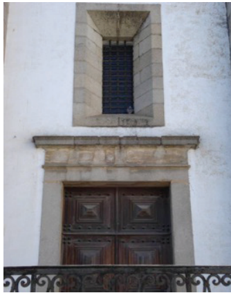
Fig.4. Igreja de Santo Antão. Évora (1577). Fachada. Detalhe do portal lateral nascente, com duplo adintelado, e abertura superior
