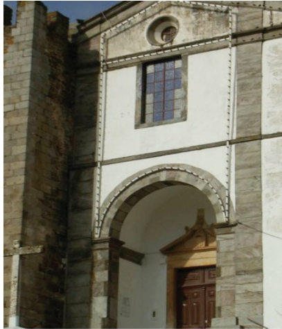
Fig.8. Diogo Pardo Osório. Igreja-Matriz de Nossa Senhora das Candeias. Mourão (ca. 1690). Fachada axial. Detalhe do portal central, entre pilares-contraforte inscritos e torreão da muralha medieval, com nártex reentrante sob arco redondo e em articulação com abertura superior e óculo no tímpano de frontão
