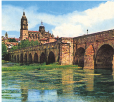
Fig.6. A ponte de Salamanca, parcialmente reconstruída
