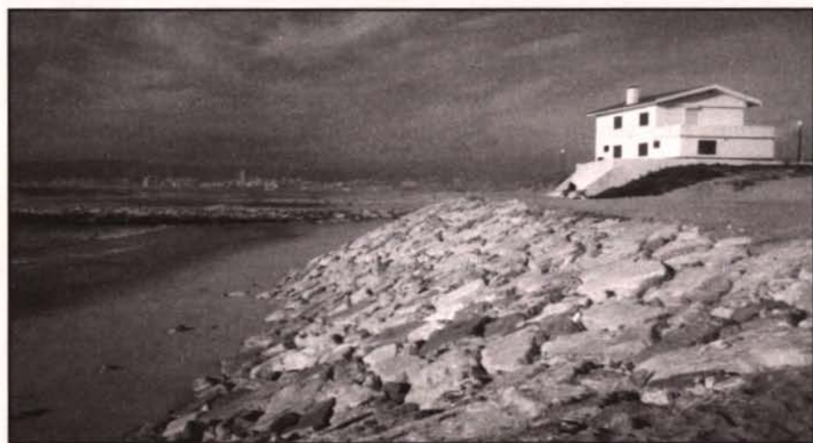
Foto 28 - Na frente marítima da Gala, tem-se investido fortemente no reforço do muro de protecção, quer para a defesa de equipamentos colectivos quer para a defesa de habitação privada. Entretanto a praia vai encurtando e deixa de ter zona supramareal (30/10/1999).
