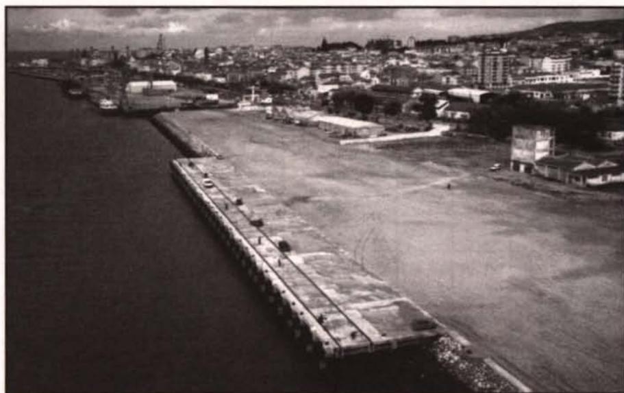
Foto 26 - Alargamento do porto comercial com a construção do novo cais de granéis sólidos (29/03/1998).
