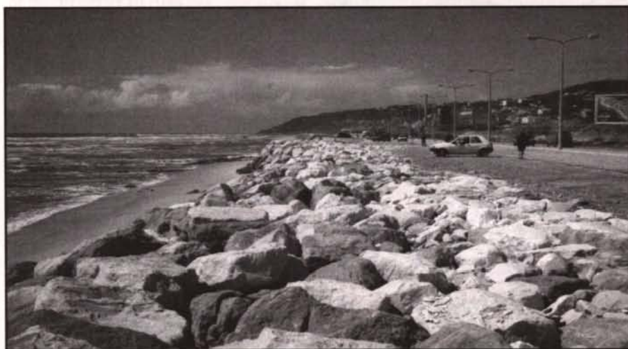
Foto 7 - Exemplo dos sucessivos erros que têm vindo a cometer-se na designada marginal oceânica da Figueira da Foz (Buarcos-Cabo Mondego) — desde a sua construção e alargamento até à expansão urbana referida na foto anterior — levando, invariavelmente, ao reforço da protecção pesada longilitoral. Esta, ao encurtar a praia, reflecte a energia da ondulação, acentuando a retirada de areia.
