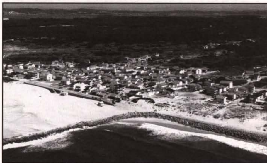
Foto 5 - Esporão transversal para retenção do areal de praia na povoação da Costa de Lavos. A erosão acentuada a sotamar desta estrutura obrigou à implantação de enrocamento aderente para evitar o recuo da duna primária (17/09/1994).
