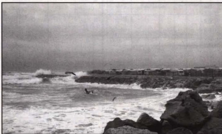
Foto 4 - A passagem de um sistema frontal, com vento forte e sobrelevação de origem meteorológica, produziu vagas de tempestade com orientação de SW (sobredimensionadas por preia-mar de Maré-Viva) que galgaram o molhe sul e atingiram o parque de campismo do Cabedelo (06/09/1998).
