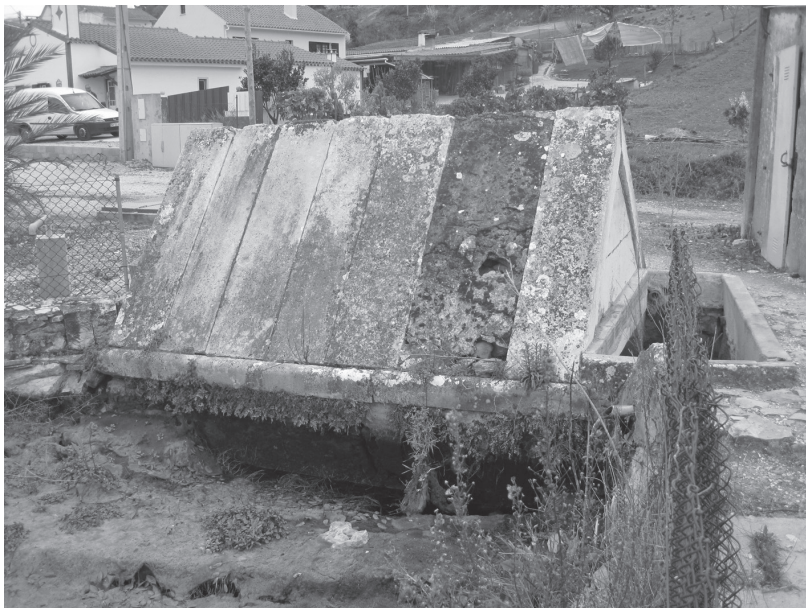
Fig. 4 – Alcobça. Abadia Cisterciense. Captação de água potável na Chiqueda de Cima. Fotog. Virgolino Jorge
