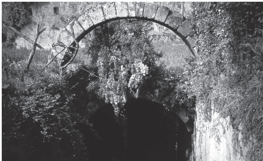
Fig. 28 – Tarouca. Abadia Cisterciense. Antigo canal das latrinas. Fotog. Virgolino Jorge
