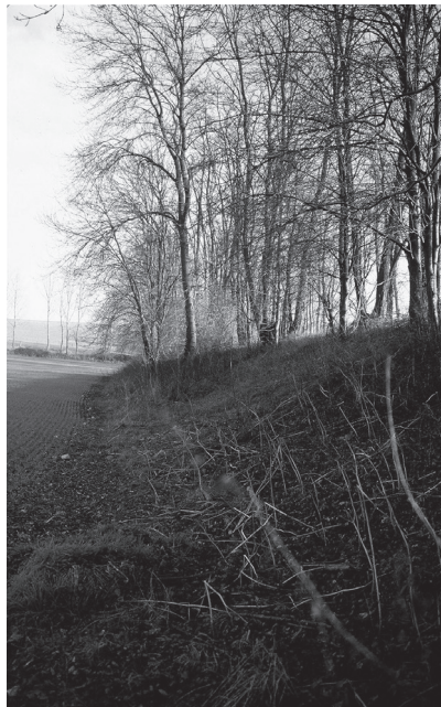
Fig. 7 – La digue protégeant le site de l'abbaye de Vauluisant
