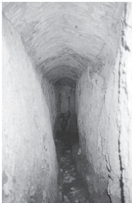
Fig. 27 – Almoester. Abadia Cisterciense. Conduta de evacuação de águas usadas. Fotog. Virgolino Jorge
