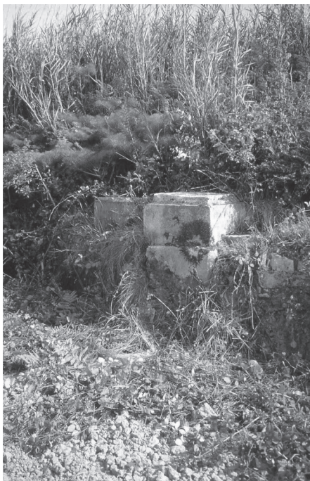
Fig. 19 – Alcobaça. Abadia Cisterciense. Transporte de água potável. Caixa de decantação. Fotog. Virgolino Jorge
