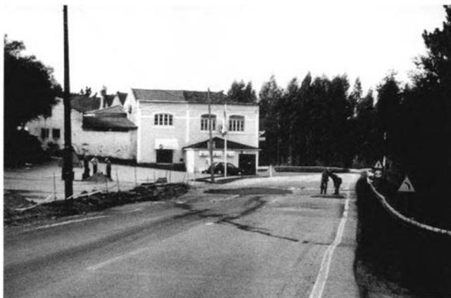
Fig. 9 – Início de um deslizamento circular na EN 17 (Janeiro de 2001).
