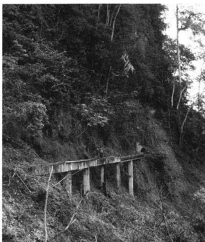
Foto 3 – Ponte-canal com 47 m de extensão, vendo-se ao fundo a entrada do túnel já existente a jusante.
