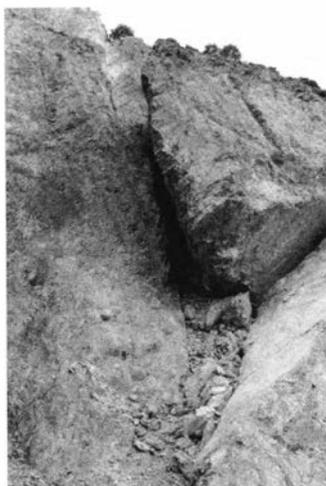
Fig. 12 – Fase intermédia de um deslizamento em cunha (Nó da Raiva, IP3, 1995).
