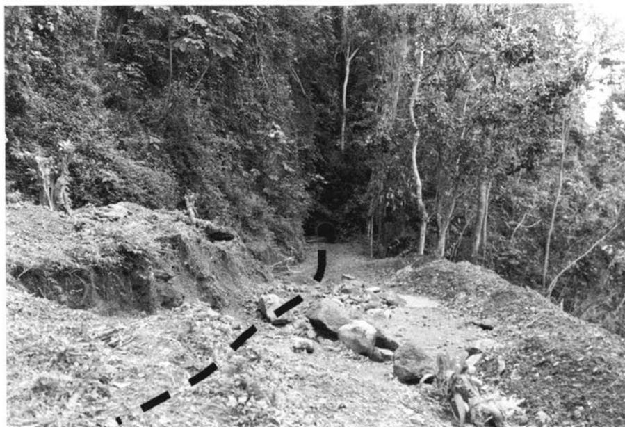
Foto 1 – Exemplo de um troço do Canal do Contador (a tracejado) coberto por depósitos de vertente. A zona encontra-se em desobstrução, vendo-se ao fundo a entrada de um dos túneis.
