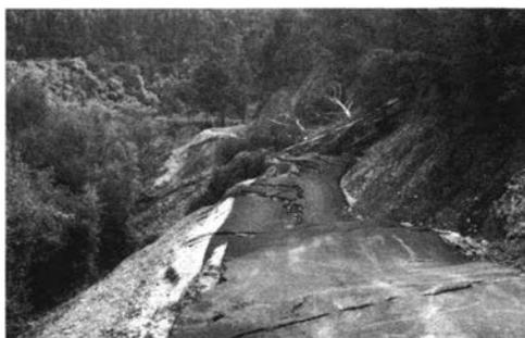
Fig. 2 – Deslizamento na estrada de acesso à ETAR de Miranda do Corvo (Abril de 2001).
