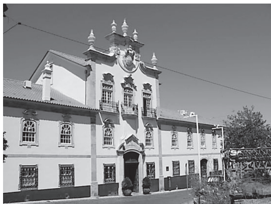
Figura 7 Melia Palácio da Lousã (após as obras de recuperação da antiga casa de família da Viscondessa do Espinhal) - junho de 2009
