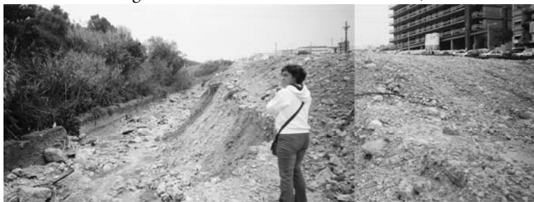
Figura 11 – Aterro ilegal no fundo do vale da R a de Sacavém (foto de 19/2/2008).
