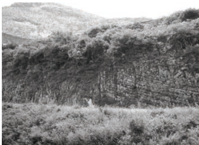
Fig. 7 – Talude da estrada da Leba – deformação frágil-dúctil em quartzitos.
