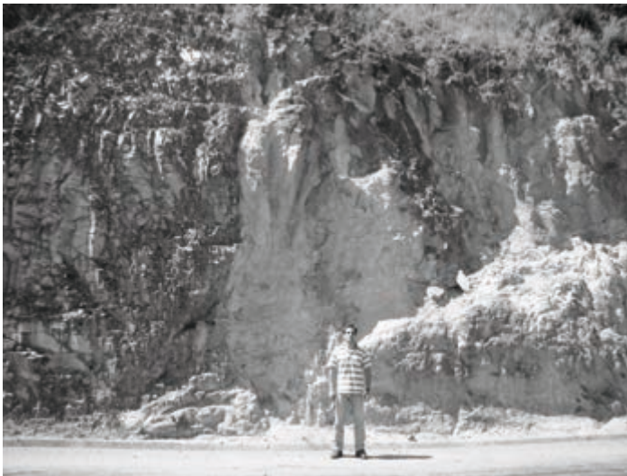
Fig. 5 – Estrada da Leba. Zona de cisalhamento frágil em granito.
