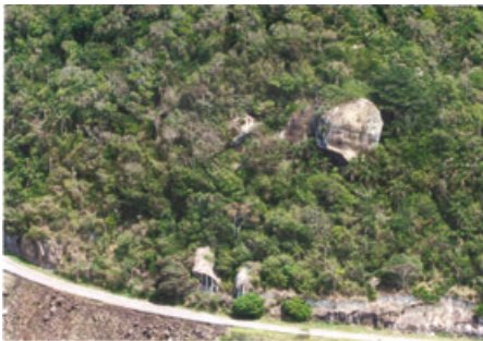
Fig. 5 - Vista da área antes do escorregamento.
