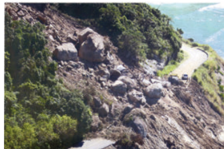
Fig. 6 - Vista da área após o escorregamento.
