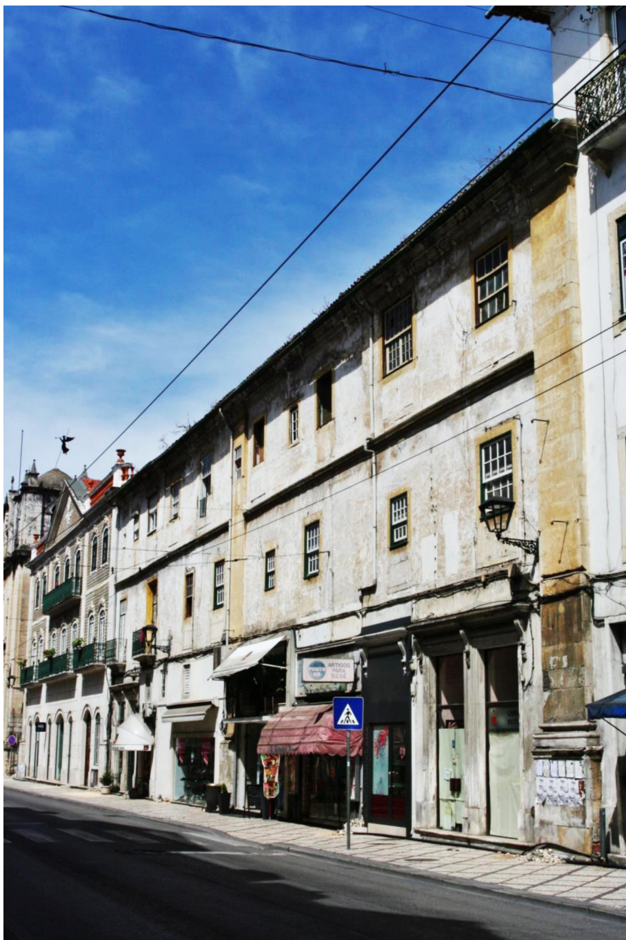
Fig. 1|| Fachada principal do Colégio de São Bernardo junto à Rua da Sofia
