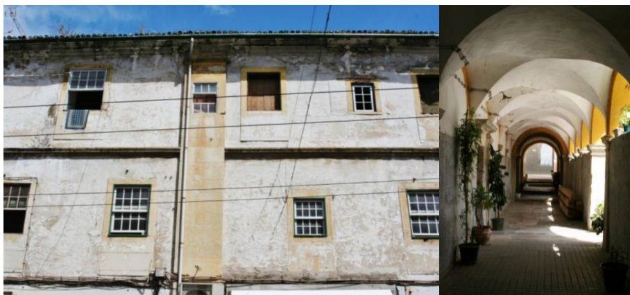
Figs. 4 e 5 || Pormenor da fachada principal e galeria do claustro sul
