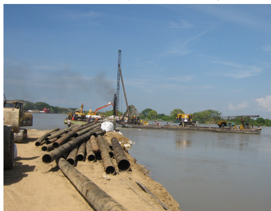
Fot. 1 - Detalle de las obras de reparación del Canal en el municipio de Santa Lucía. Fuente: HERNANDEZ, Y., 2010.
