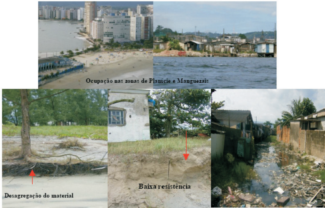
Fotos 3,4,5,6 e 7: Verticalização do uso urbano em zona de planície costeira, ocupação de mangues e processos relacionados à erosão costeira e inundações.
