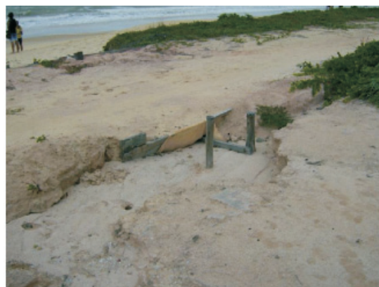
Fotos 8 e 9: Processo erosivo em Zona de Tabuleiros e disposição do material em zona de terraços resultantes da erosão.
