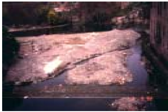
Fot. 7-A - Aspecto de pormenor da praia fluvial de Avô, em Julho de 1988, após a enxurrada de 23 de Junho desse ano.
