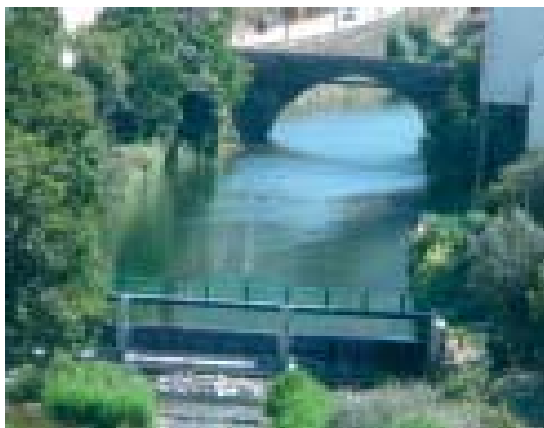
Fot. 23-A - Vista geral da piscina fluvial da Vide, após as obras recuperação (06 de Setembro de 2009) .
