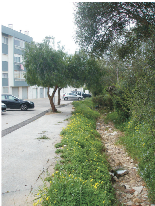
Fot. 2 - Alapraia, São João do Estoril. Vala que se transformou em "rio" caudaloso durante a noite de 25 para 26 de Novembro de 1967. Os prédios são posteriores e ocupam um espaço, então, parcialmente cultivado. Aí existiam várias barracas de madeira, uma das quais habitada, que foram inundadas enquanto um muro transversal serviu de barragem. Com o colapso do muro as águas destruíram e levaram os seus restos.
