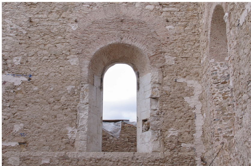
FOTO 16 – Perspectiva de uma janela pertencente ao refeitório identificada no decurso dos trabalhos
