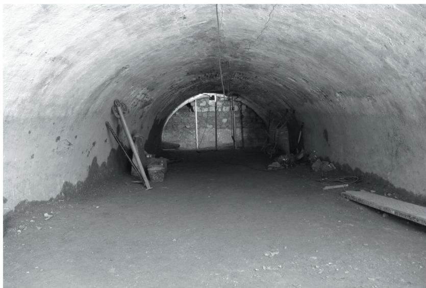
Foto 18 – Perspectiva interior da estrutura subterrânea/cisterna identificada nas escavações
