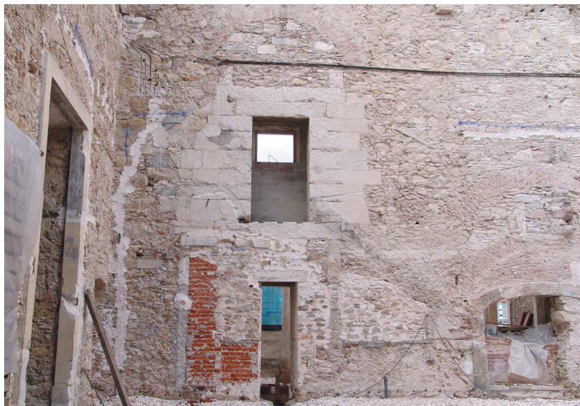
FOTO 15 – Pormenor do púlpito do refeitório jesuíta que se encontrava emparedado
