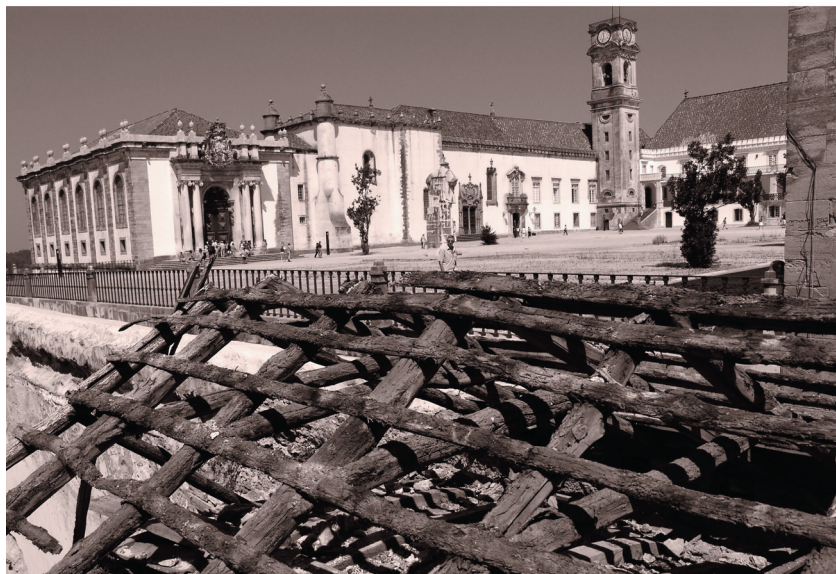
Foto 11 – Perspectiva da intervenção no telhado do Colégio da Trindade
