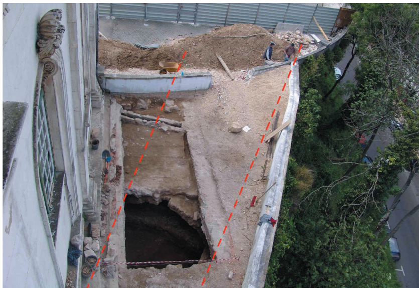
Foto 17 – Implantação da estrutura subterrânea/cisterna no topo norte do laboratório
