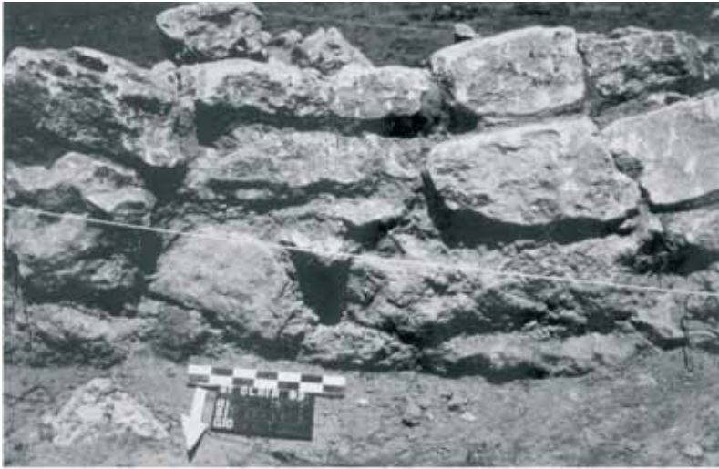
FIG. 17 – Pano interior da muralha
