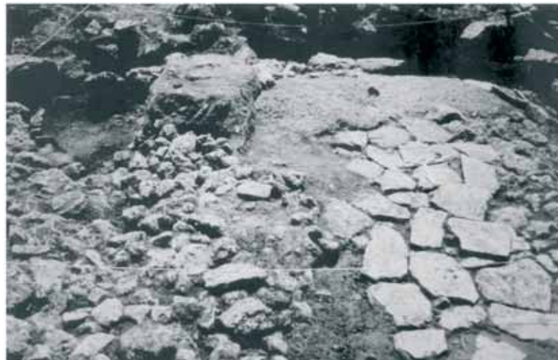
FIG. 16 – Pavimento sobre enrocamento
