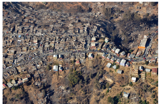
Fig. 5 - Visión general de un sector afectado por el incendio de Valparaíso en abril de 2014. Se muestra la destrucción casi total en sectores de altas pendientes (Fuente: Fotografía: Conaf, 2014).
