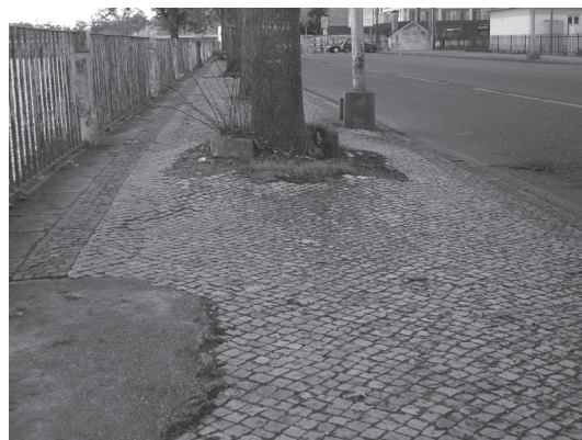
Figura 3 Caldeira estreita e levantada pelas raízes da árvore, Coimbra, nov. 2012, marginal ao rio Mondego.
