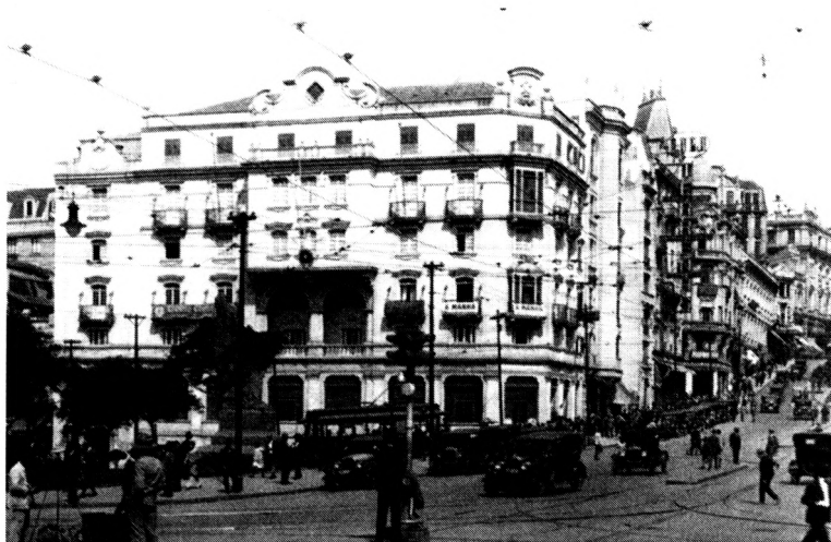
11. Casa José Moreira no Vale do Anhangabaú, em São Paulo.
