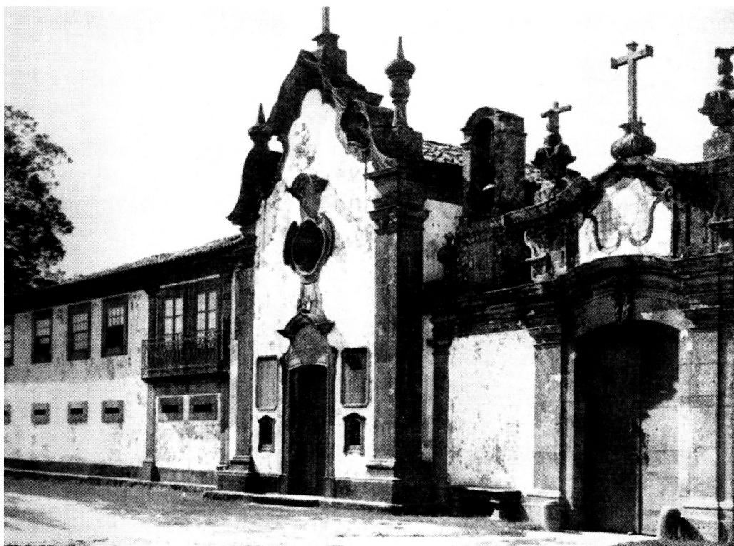
11. Solar típico da região do Minho construído em meados do século XVIII, em que se nota a presença marcante da capela através do frontão de linhas barrocas.
