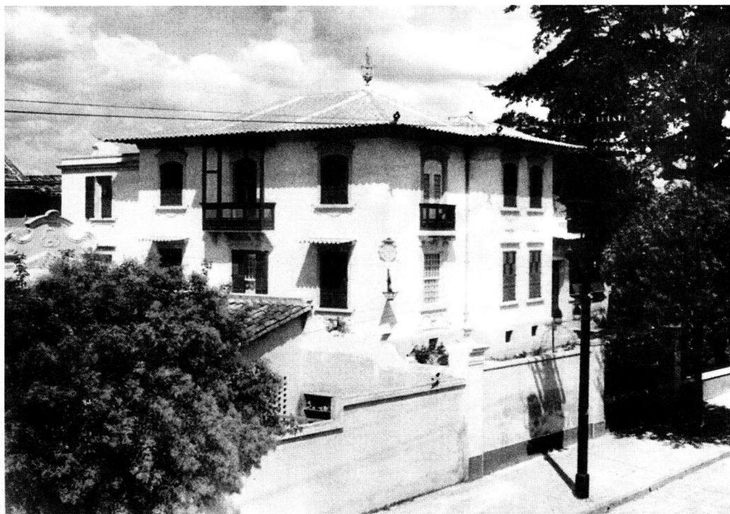
24. Vista da casa tirada da rua taguá
