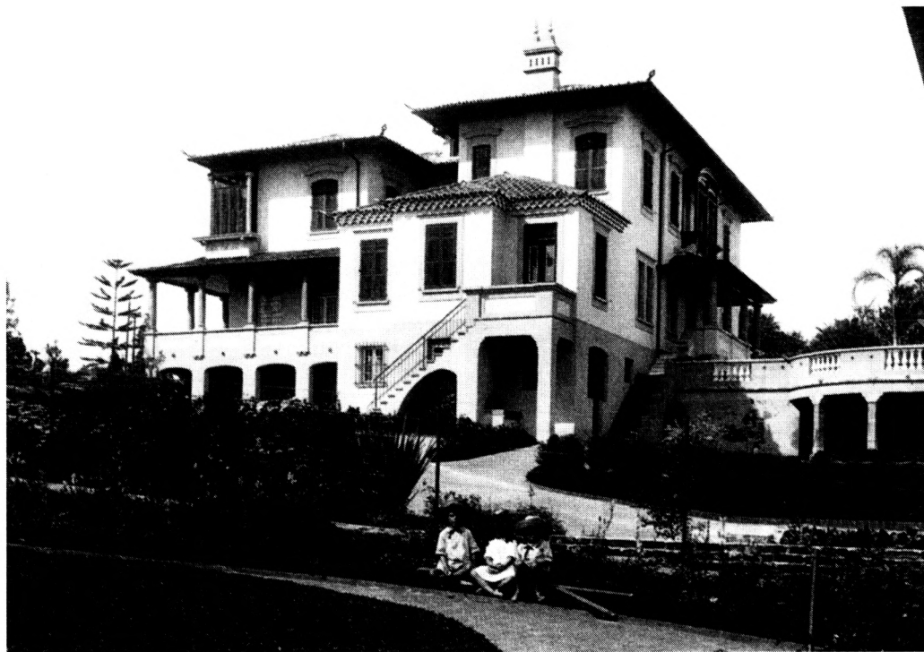
22. vista da fachada posterior
