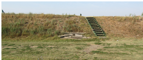
Terraplanagem do canal navegável
