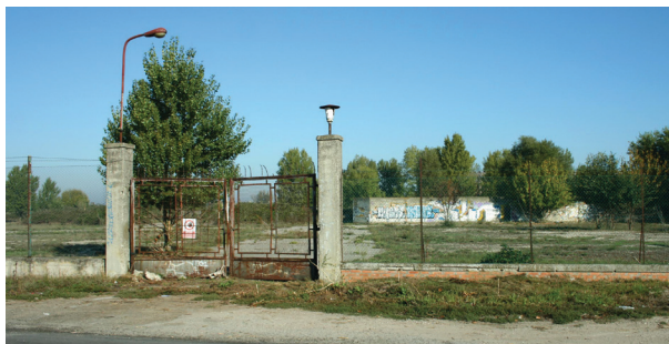
Entrada na SP15, "Via del Mare"
