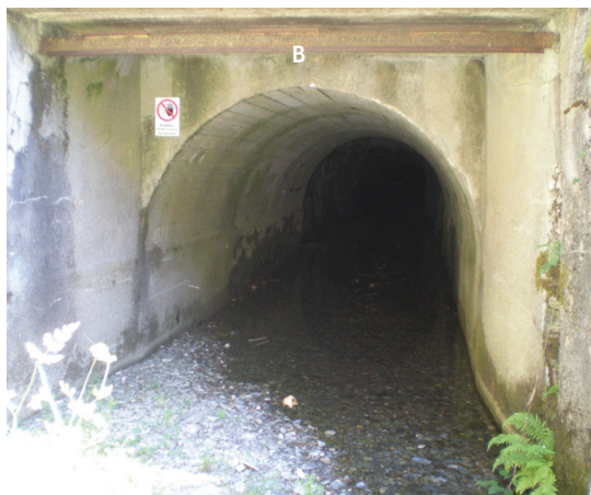
Fot. 4 - Aspetos da entrada do túnel da Castanheira: A - Vista geral, com pormenor do açude muito assoreado; B- Pormenor da entrada (fotografias de Carlos Cruz).
