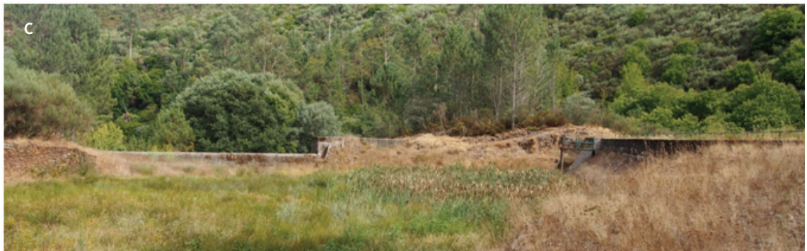
Fot. 1 - Açude da Castanheira: A - Pormenor da vista frontal; B - Detalhe, visto do interior; C - Visão geral, tomada do interior, com o açude à direita da fotografia e o descarregador de cheias à esquerda (fotografias de Luciano Lourenço).
