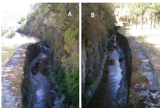
Fot. 9 - Aspetos de pormenor do canal de adução do Ceiroco. A - Vista de montante; B - Vista de jusante (fotografias de Carlos Cruz).
