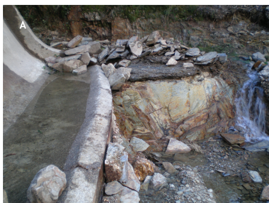
Fot. 19 - Vistas do xisto (rocha-m e) na base da rotura, exposto pela eros o h drica. A - Pormenor, em vista paralela ao desenvolvimento do t nel. B - Detalhe da vista frontal (fotografias de Carlos Cruz).
