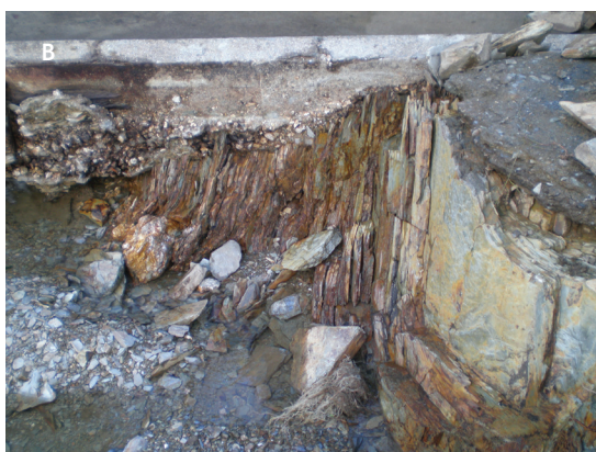
Fot. 19 - Vistas do xisto (rocha-m e) na base da rotura, exposto pela eros o h drica. A - Pormenor, em vista paralela ao desenvolvimento do t nel. B - Detalhe da vista frontal (fotografias de Carlos Cruz).
