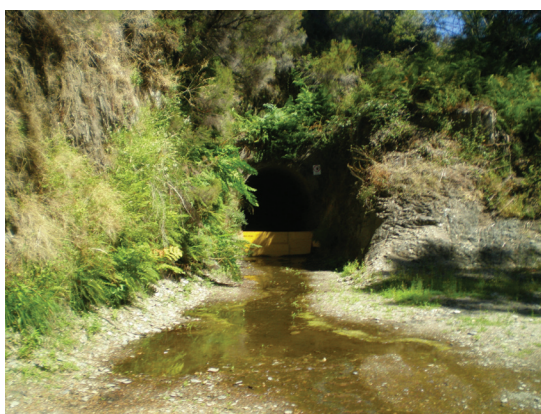
Fot. 8 - Açude do Ceiroco: Pormenor da saída do túnel do Alto Ceira, com a passagem barrada devido às obras de conservação (fotografia de Carlos Cruz).
