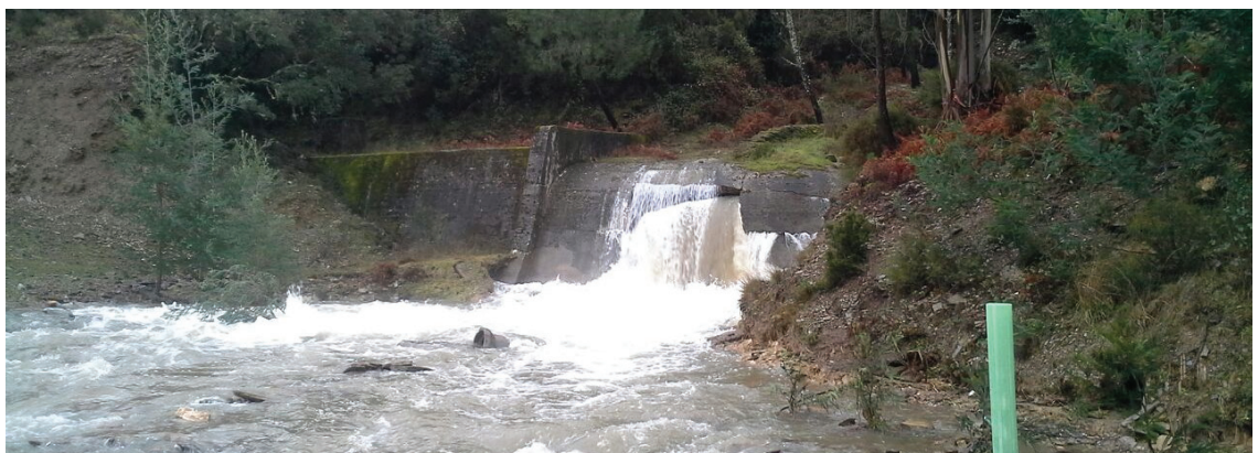
Fot. 17 - Pormenor da secção de rutura em pleno escoamento, 31 de janeiro de 2015 (fotografia de António Oliveira, CDOS de Coimbra).
