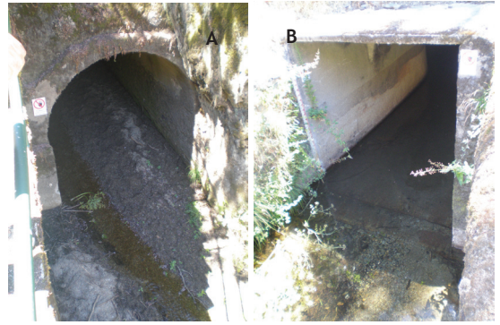
Fot. 5 - Pormenores do açude do Tojo: A - Saída do túnel da Castanheira; B - Entrada do túnel do Tojo (fotografias de Carlos Cruz).
