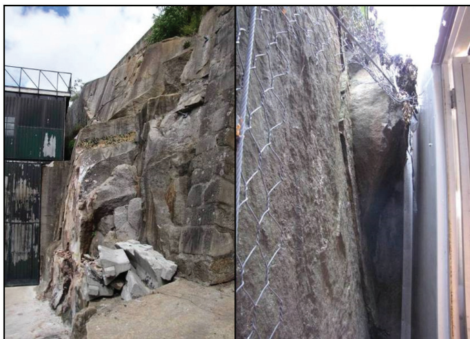
Fot. 10 - Pregagens do talude em granito na rua da Barroca (Salvador Almeida). Photo 10 - Nailing the granite slope in the Barroca Street (Salvador Almeida).
