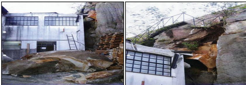
Fot. 9 - Mostrando o bloco de granito, os vestiários e o local donde se desprendeu (Fonte: Arquivo Bombeiros Sapadores e Proteção Civil de V. N. de Gaia).
