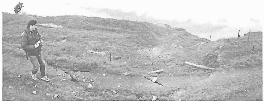
Foto 12 - Cabeceiras do movimento e plano de ruptura principal do deslizamento.
