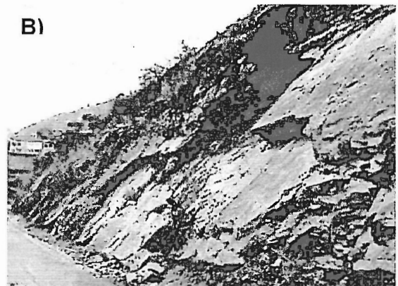
Foto 6 - A) Movimento activo em materiais detriticos assentes, em descontinuidade, sobre as bancadas metassedimentares, lado-a-lado com um movimento fóssil, ambos na margem esquerda do Douro, na E.N. 222; B) Note-se a existência de planos de descontinuidade favoráveis à ocorrência de deslizamentos planares de blocos ( rock block slide ) ou de mecanismos do tipo " Buckling " - caso particular dos deslizamentos planares de blocos que envolve placas fracturadas, na margem direita, em sectores onde não há cobertura detritica.
