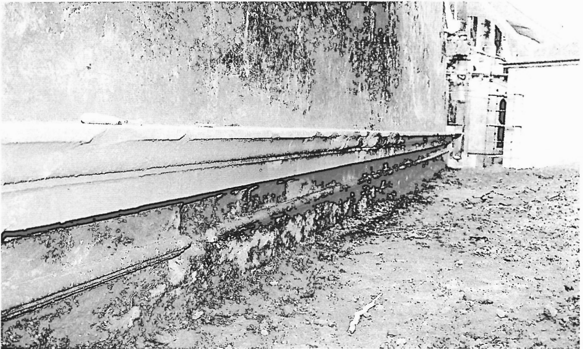
Foto 36 - Friso arquitectónico na Ala Nascente do "Claustro Sul", frente à Capela do Desterro, recentemente desenterrado e que, a nível de 1º andar, teria sido concebido para estar a uns 5 m do solo exterior (P.TAVARES, 1999).
