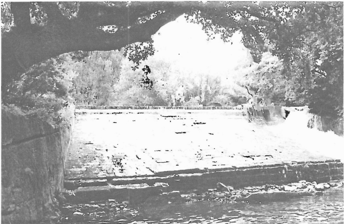
Foto 38 - Açude no Rio Alcobaca, obra impressionante cuja origem remonta ao século XVI, para moinho de papel e para irrigação dos Campos da Maiorga. Foi posteriormente adaptado para produção de energia eléctrica para a já encerrada Fábrica de Fiação e Tecidos. Símbolo de grandeza hidráulica cisterciense e pós-cisterciense, hoje tristemente ao abandono (P.TAVARES, 2000).
