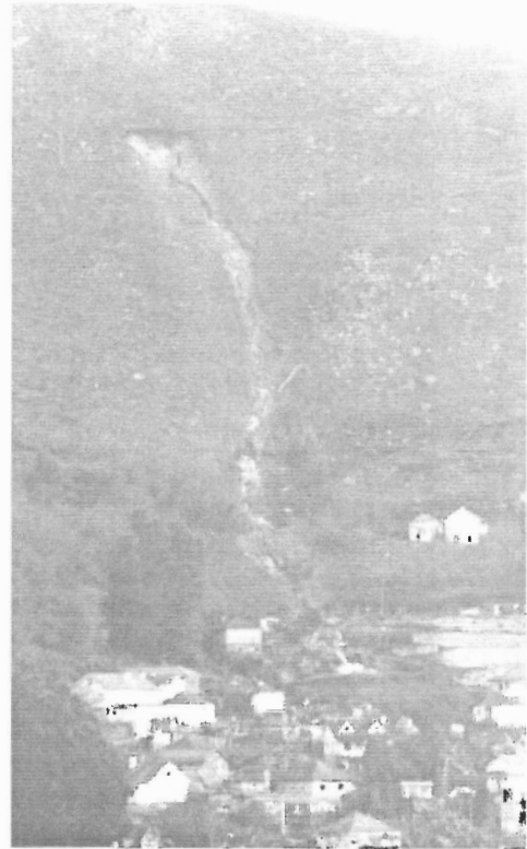
Foto 6 - Fluxo de detritos de Frades (Arcos de Valdevez).
