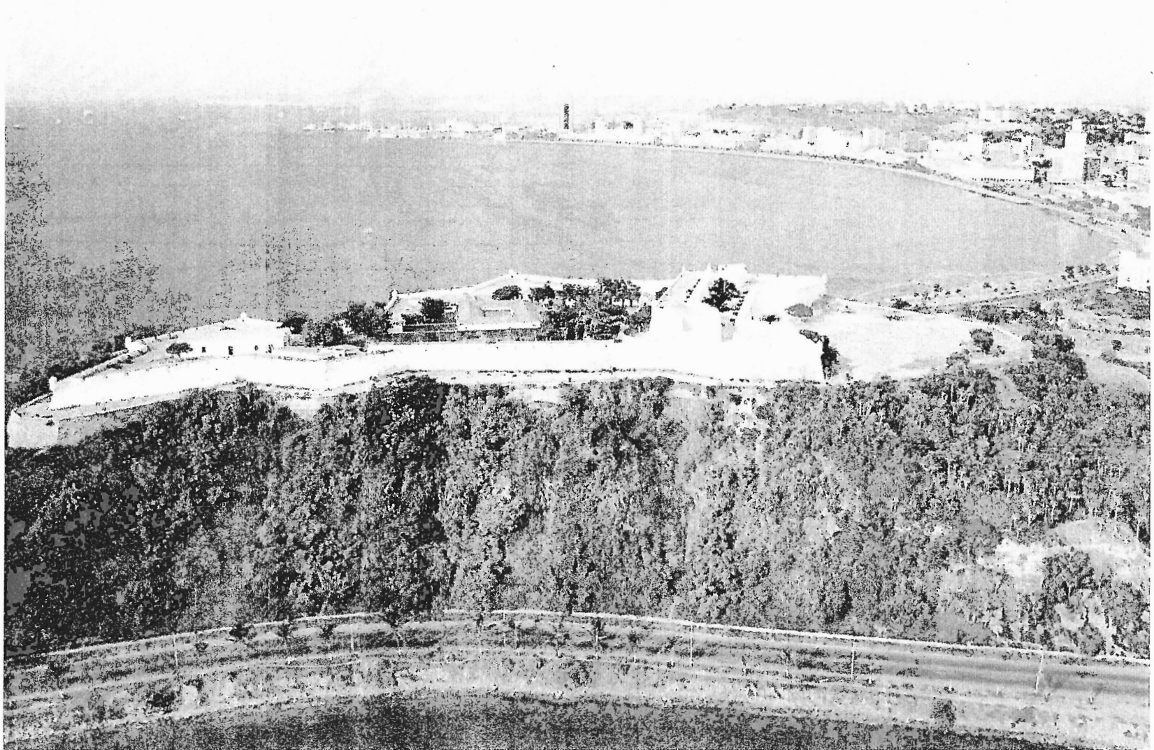
Fig. 3 - A Fortaleza de São Miguel, o seu morro e uma vista panorâmica da baía e da cidade de Luanda. Ao fundo, as arribas da Ponta das Lagostas.
