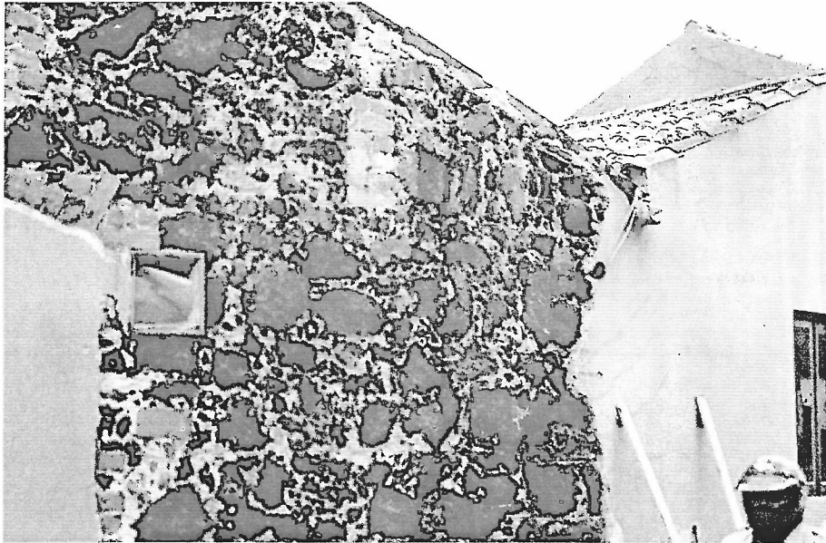
Fot. 1 - Construção antiga feita em surraipa.
