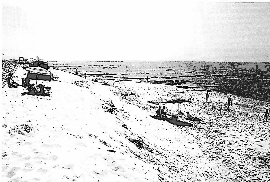
Foto 2 - Aspecto do areal entre o Forte de Buarcos e o Teimoso em 17/07/1996. Note-se o grande degrau erosivo talhando a praia alta. O adjacente enrocamento da avenida marginal foi posteriormente destruído na totalidade. A fotografia foi tirada para sul, a partir do restaurante Costa.
