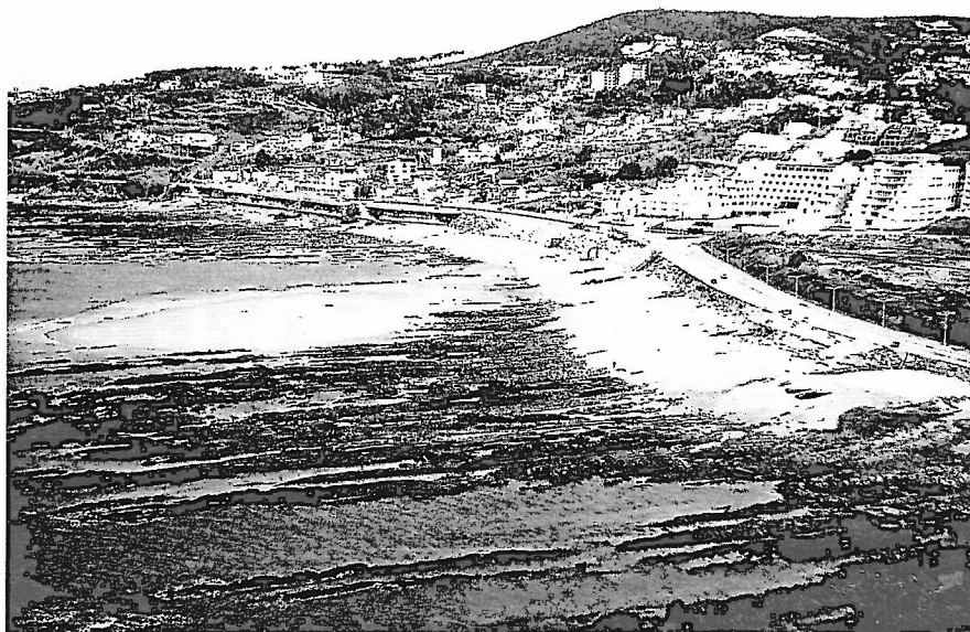
Foto 6 - Panorâmica aérea do troço litoral entre o Cabo Mondego e o cemitério de Buarcos, na baixa-mar de maré viva, evidenciando a grande exposição do substrato rochoso e os trabalhos de reparação do enrocamento da avenida marginal. Note-se que grande parte da escassa cobertura de areia que é visível se acumulou durante um curto período (1ª semana de Janeiro de 1998) com forte ondulação de NW (atingiu cerca de 5 m de altura, ao largo). No lado direito da fotografia observa-se a extremidade NW da área onde se executam trabalhos de loteamento para a construção de uma densa frente edificada junto da marginal.
