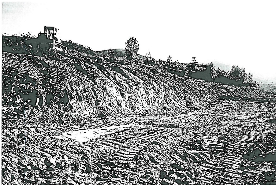
Fot. 2 - Construção de socalcos num dos “cabeços” da área de estudo.
