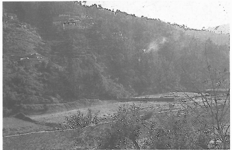
Photo 3 - Mondego, rive gauche, en amont de Coimbra. Murs transversaux en schiste bâti sur le lit d'inondation.
