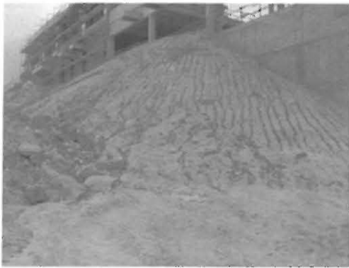
Fotografia 3 Material de aterro que serve de suporte à obra do novo Hospital Pediátrico de Coimbra.
