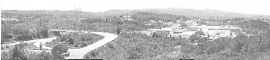
Figura 9 Visão parcial da Plataforma de Cernache - Assafarge
