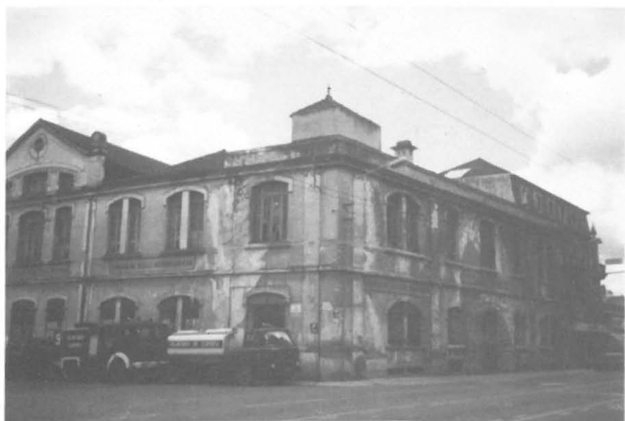
ESTAMPA 4 — A antiga Fábrica de Azulejos Hidráulicos Joaquim Gomes Porto & Irmão (Coimbra) em breve dará lugar a um moderno Centro Comercial ( Diário de Coimbra , 18 de Dezembro de 1990).
