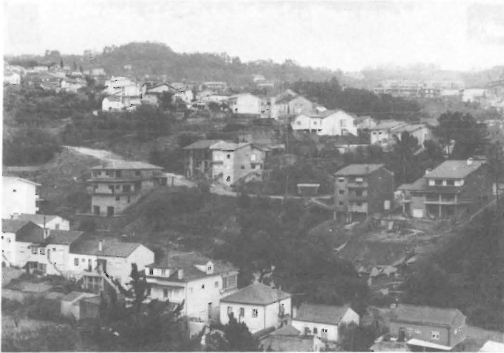
Fot. 5 - Destruição do muro de uma habitação em consequência de deslizamentos (vale da Av. Elísio de Moura).
