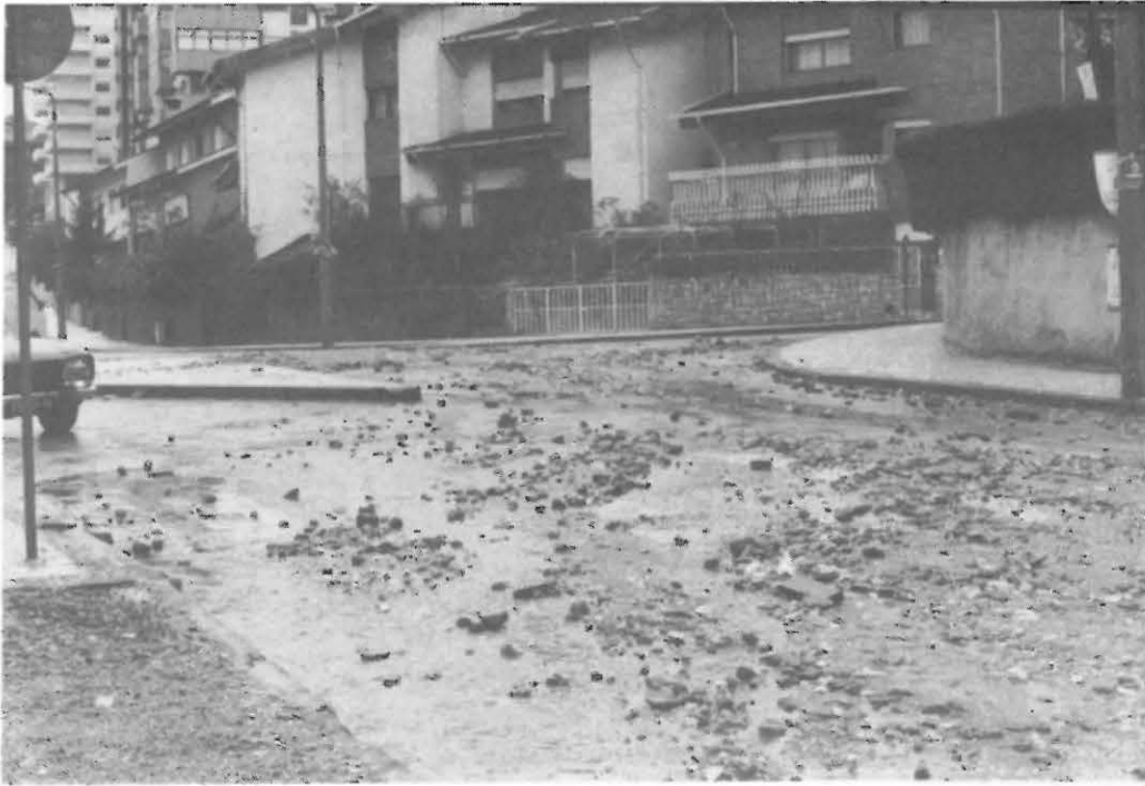
Fot. 1 - Aspecto da rua Gago Coutinho (Solum), à entrada da praçeta, após um episódio de precipitação intensa (22/12/89).
