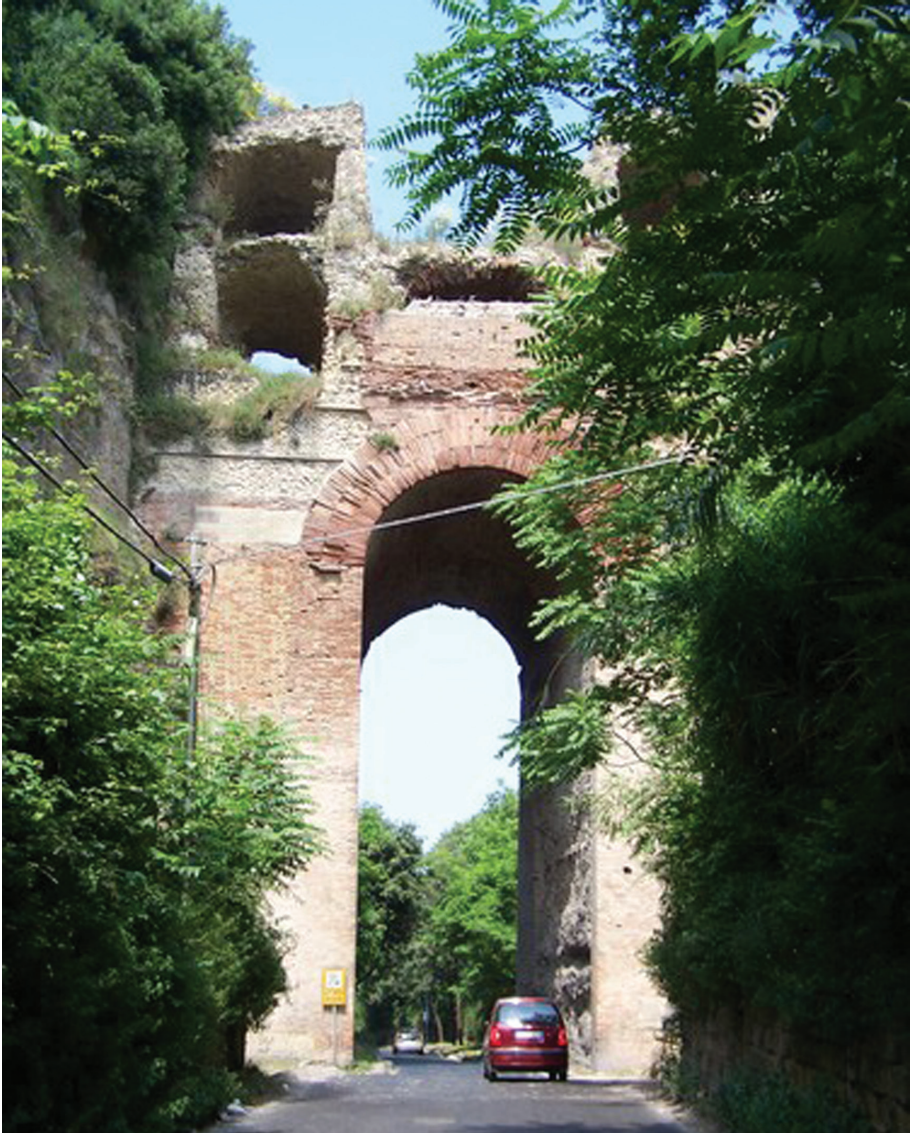
Fig.2 - O Arco Felice , viaduto da Via Domitiana entre Pozzuoli e Cumas.
