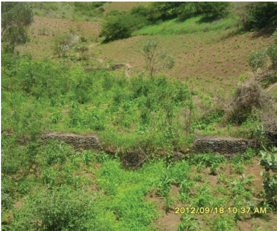
Fot. 8 - Pequeno dique de contenção da erosão na zona de Pinha (Fonte: F. Sanches, 2012).
