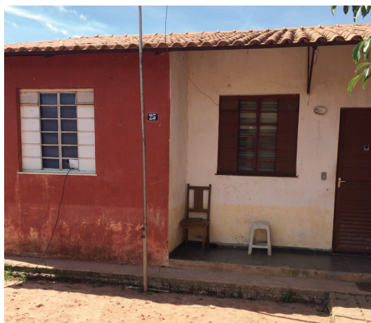
Fot. 1 - Marcas da inundação de janeiro/2012 em uma residência na localidade de Três Vendas (Fotografia de Cármen Ferreira, abril de 2015).
