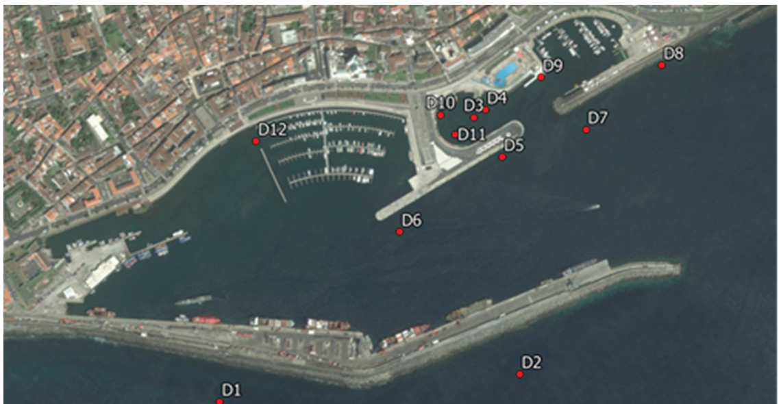
Fig. 4 - Estruturas seleccionadas para avaliação das consequências (J. Rodrigues, 2014).
