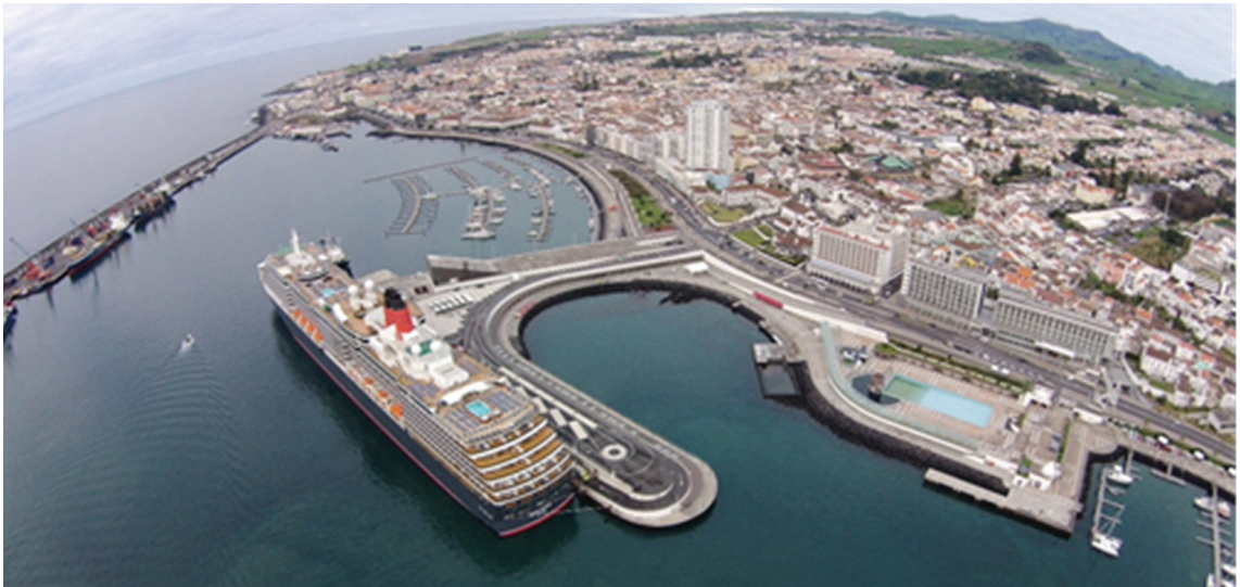
Fig. 6 - Fotografia aérea do porto de Ponta Delgada ( https://www.facebook.com/pages/Porto-de-Ponta-Delgada/187997584578504 ).
