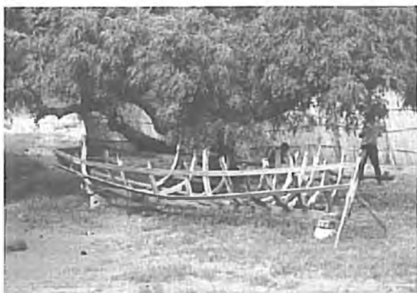
Figura 2. A lança do Calisto em construção.
