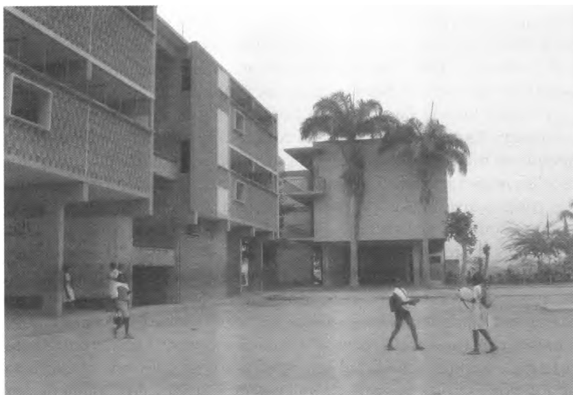
Figura 6 - Liceu Nacional do Lobito ou Almirante Lopes Alves, actual Escola Secundária Comandante Saydi Mingas, Francisco Castro Rodrigues, 1966 [Foto: Ana Vaz Milheiro, 2009].
