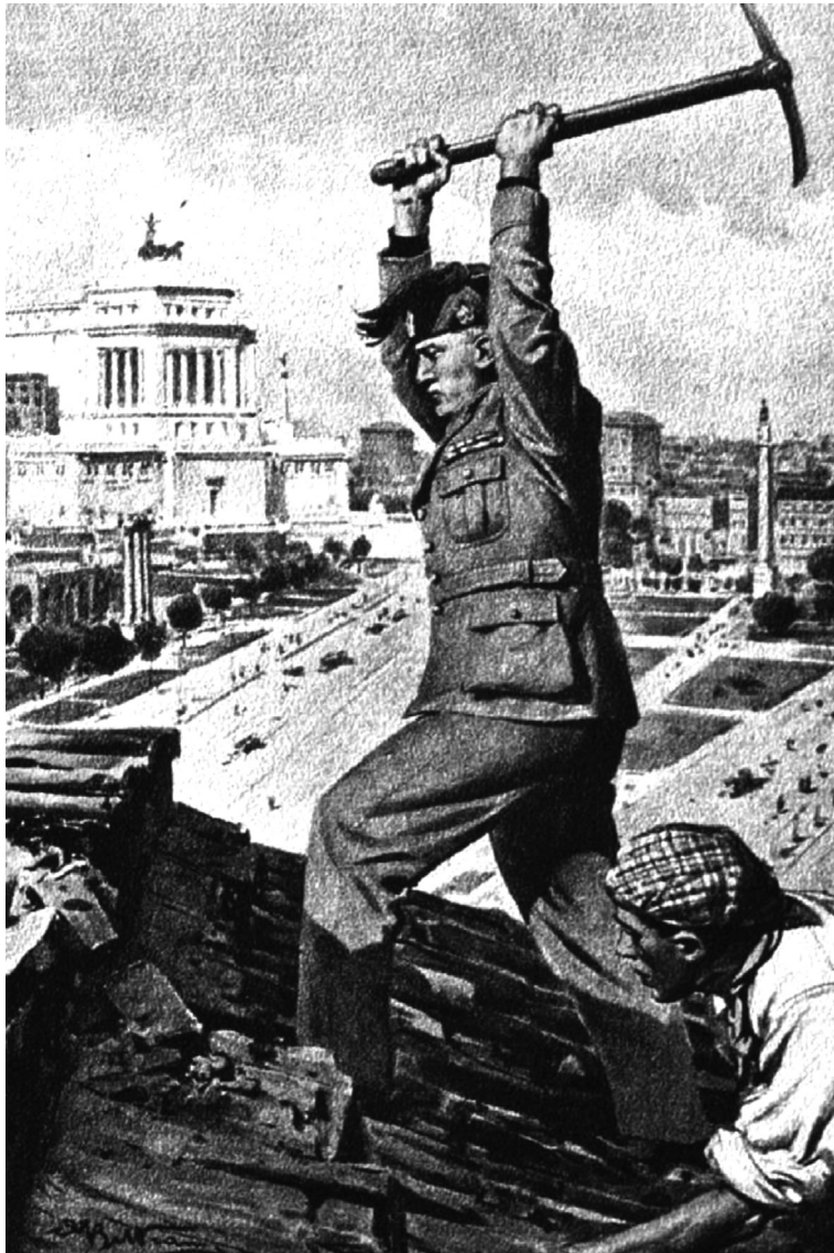
FIG. 9 – Cartaz de propaganda mostrando Mussolini iniciando trabalhos de demolição em Roma. Ao fundo vê-se a nova Via dei Fori Imperiale. (La Domenica del Corriere: 3.3.1935).
