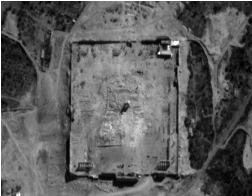
FIG. 15 – Imagens de satélite das ruínas do templo de Bel, em Palmira, antes e depois da destruição em Agosto de 2015. (Imagem UNITAR).
