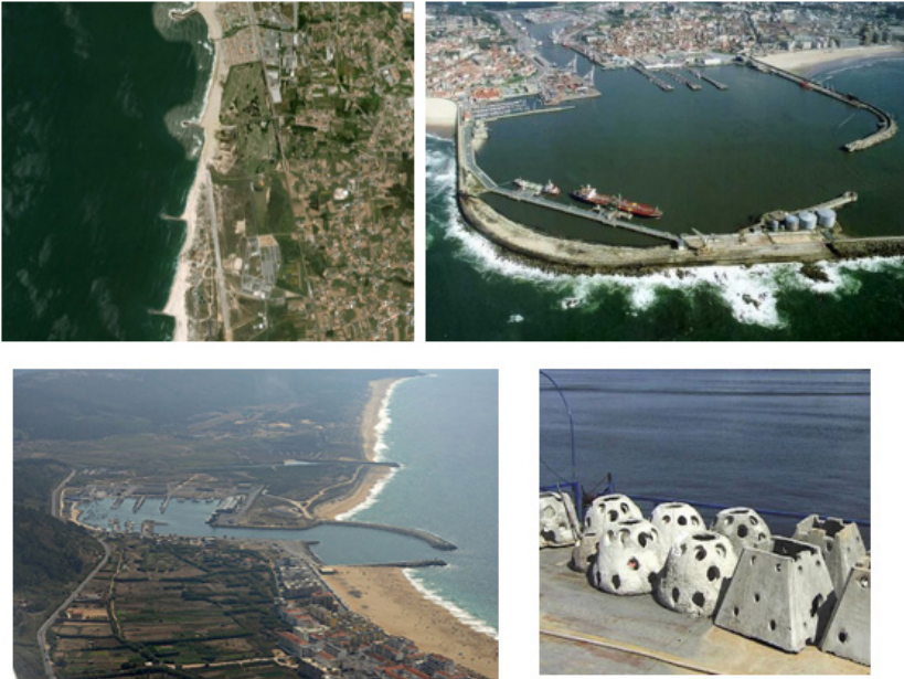
Obras de proteção costeira
