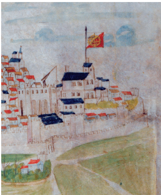
Figura 4. 18. Évora, séc. XVI: pormenor do Convento de São Francisco em construção. Pormenor da Iluminura da cidade de Évora . Foral manuelino de Évora, 1501, Arquivo Municipal de Évora.
