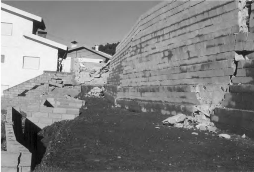
Fot. 56 – Roturas no muro de suporte da estrada da base do talude e detalhe do ponto de inflexão.
