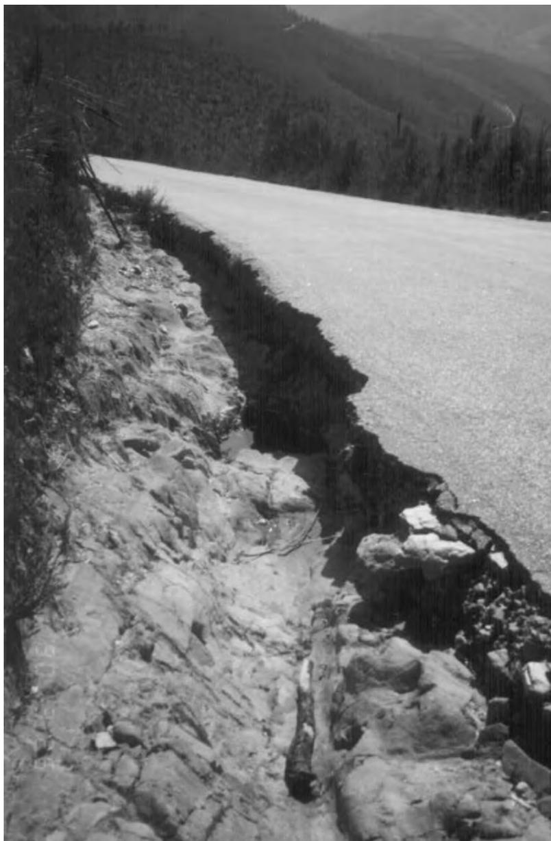
Fot. 53 – Pormenor da valeta da entrada Cavaleiros de Cima-Cruzamento da Teixeira. Notar a berma da estrada completamente destruída e o trabalho de sapa sob o asfalto. A migração da valeta em direção ao asfalto é facilitada e condicionada pelas numerosas fraturas e pela fraca resistência do xisto.
