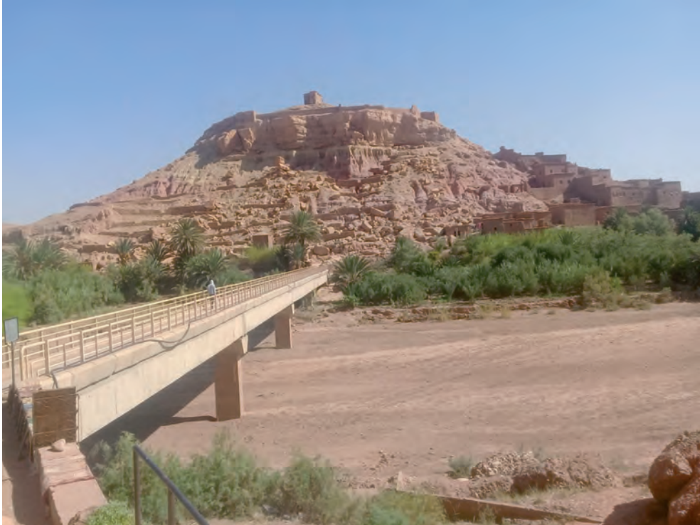
Photo 3 - Pont pour les piétons pour garantir l'accessibilité du site tout au long de l'année, même en période de crue. Source: Photo de terrain, 17.09.2017
