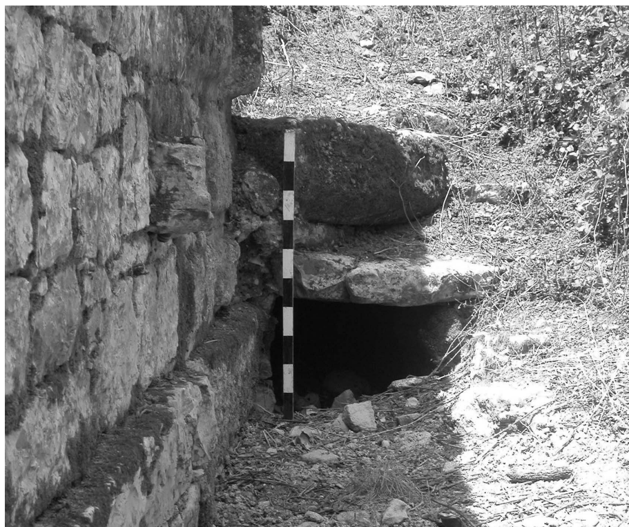
Figura 4. Viaduto de Conimbriga, aspeto da canalização.
