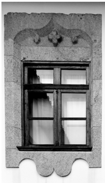
Fig. 12 – Janela localizada no lado Norte do pátio interior da casa, onde se verifica a provável incorporação do remate superior de filiação quinhentista. Fotografia das autoras.
