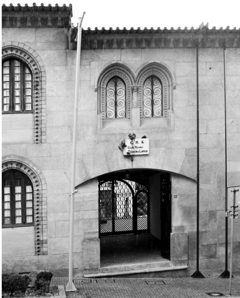
Fig. 8 – Portão de entrada do edifício, rematado por uma janela geminada. Fotografia das autoras.
