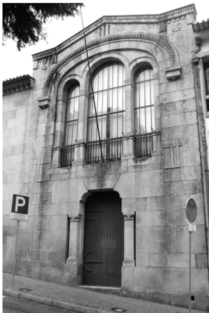
Fig. 14 – Parte da fachada correspondente ao atelier principal. Fotografia das autoras.
