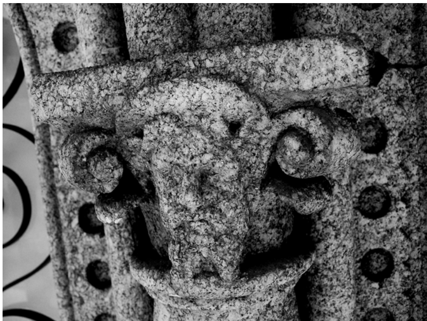
Fig. 9 – Pormenor do capitel do mainel que separa a janela geminada por cima do portão de entrada. Fotografia das autoras.
