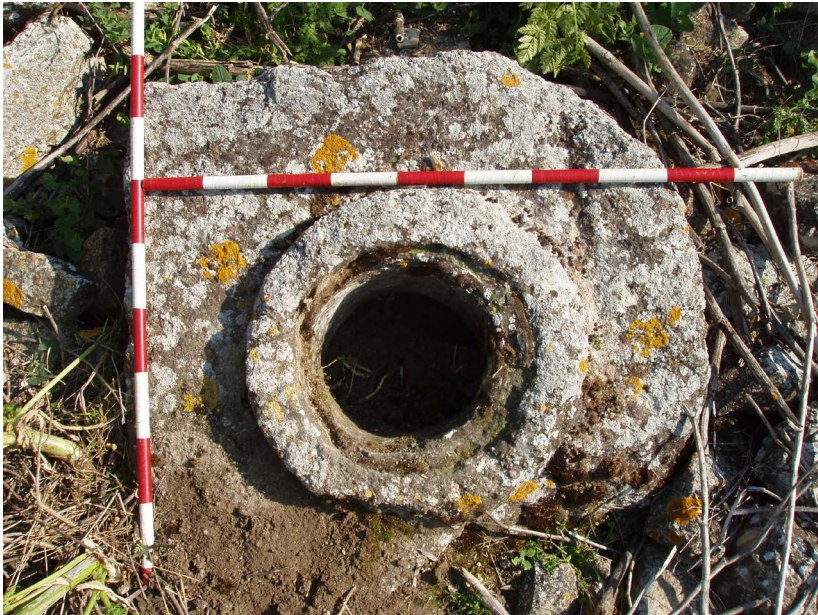
Figura 23. Fotografia de pedra de “sifão” do aqueduto de Cádiz (Valle de los Arquillos), (fotografia de Lázaro Lagóstena Barrios).
